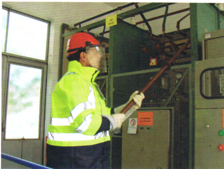
Praktisches Vormachen der 5 Sicherheitsregeln im Kompetenzzentrum Arbeitssicherheit der MIT Sicherheit AG in Rorschach.
